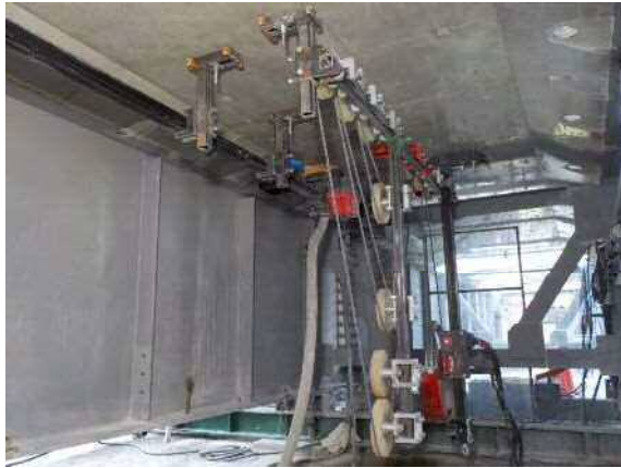
写真1 乾式水平切断装置
