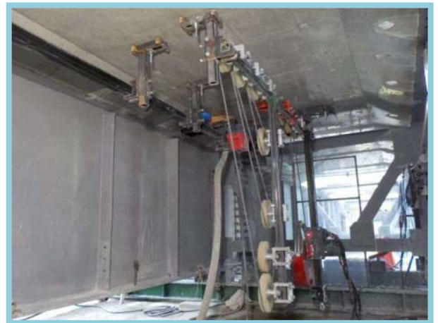
乾式水平押切ワイヤーソー装置
