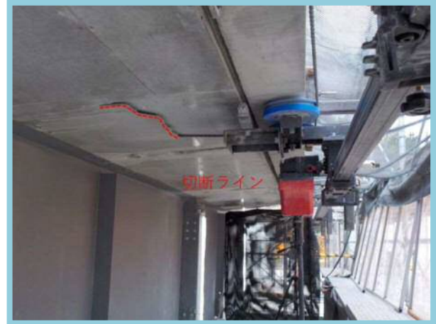
床版切断状況
