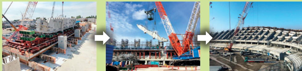
1 上部スタンドを地上にて仮組み立て
