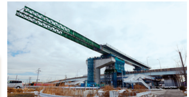
橋桁を台車に乗せて移動させる「送出し架設工法」で建設しました。
