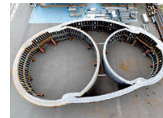
製作時(仮組立状況)
