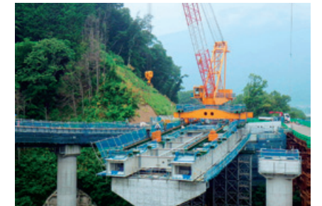
トラベラークレーンによる架設
