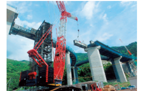
750tクレーンによる架設
