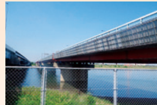
市川大橋全景
