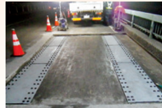
鋼床版補修の様子
