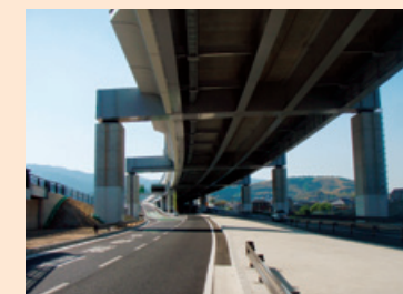
完成した長岡京第4高架橋
