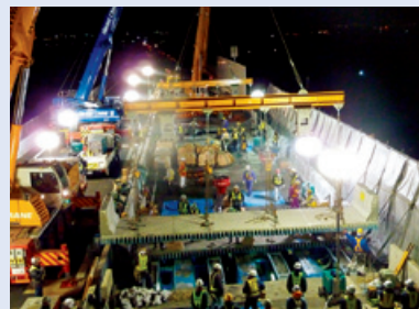
西名阪自動車道 御幸大橋床版取替工事
