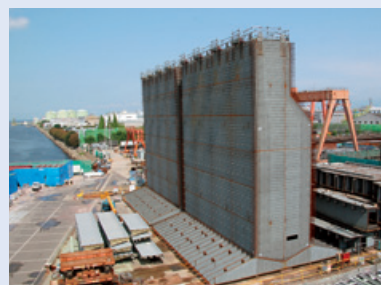
防波堤施設(ハイブリッドケーソン)
