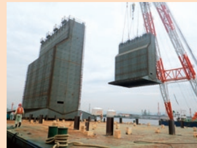
台船積み込み状況
