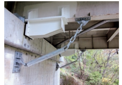
落橋防止装置「パワーチェーン」
