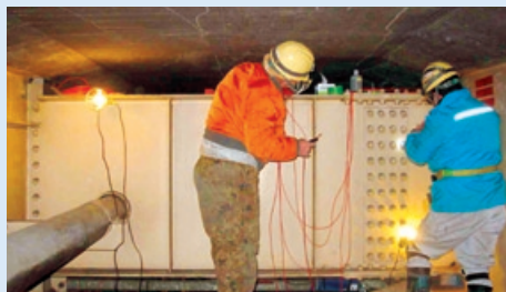
現場計測状況
