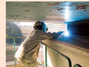
サイドブロック溶接作業
