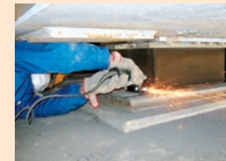
溶接箇所ケレン
