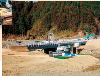
架設完了(4月4日)
