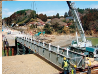
仮橋架設(4月1日)
