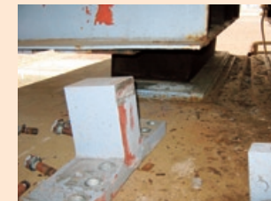
サイドブロック破損時
